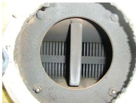
**Dispositif de rinçage automatique de l'échangeur de condensation :**
